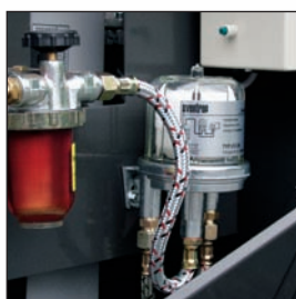
Стандартный "Tiger loop" (жидкотопливный деаэратор).
